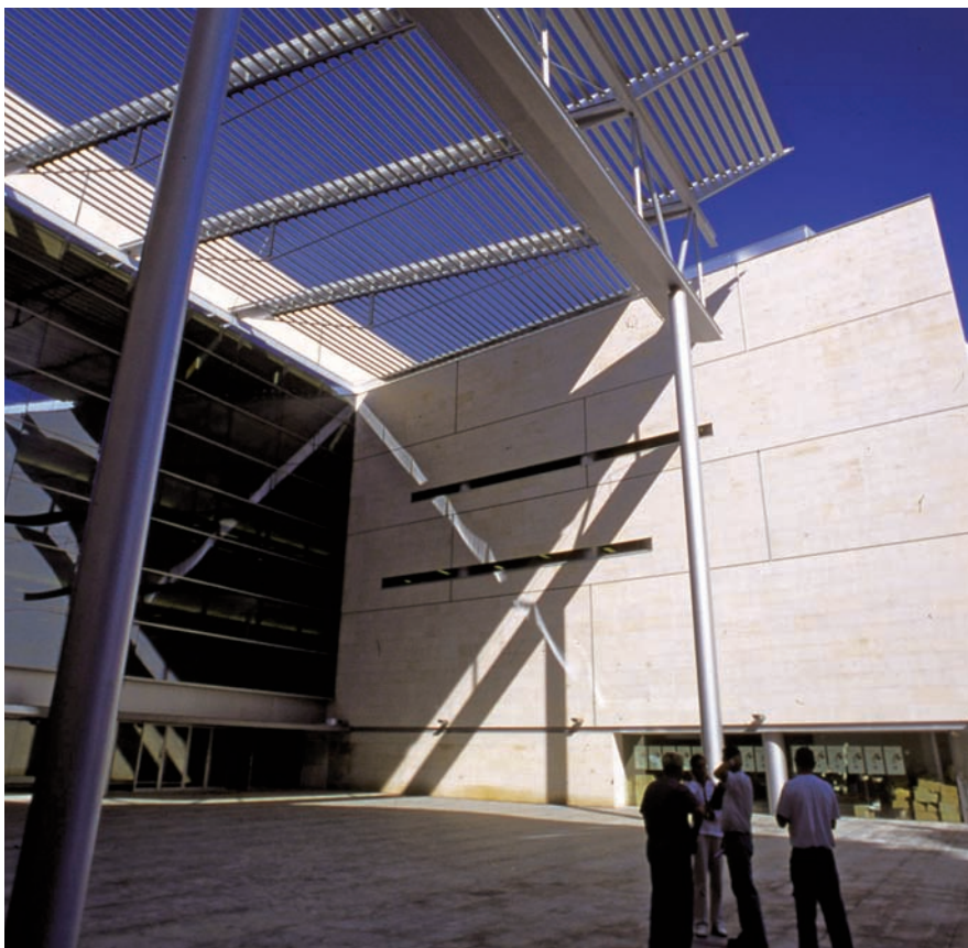
Instal·lacions de l'Institut del Teatre, a la Plaça Margarida Xirgu de Barcelona.
