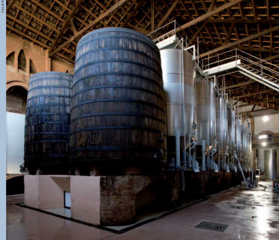
Tines del celler cooperatiu de Falset, recolzades sobre voltes tradicionals per aïllar-les del sòl.
