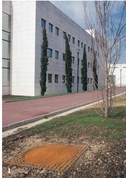
1. Davant l'edifici del Servei Informàtic de la UAB també s'ha instal·lat una arqueta per realitzar la connexió.
