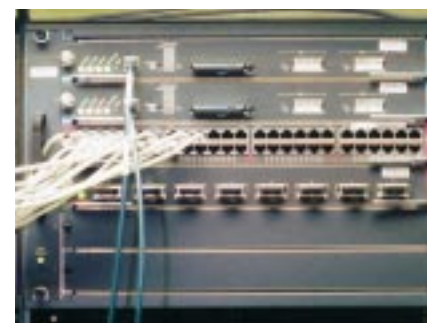
El nou Cisco 6506 amplia les prestacions de commutació del CATNIX.
