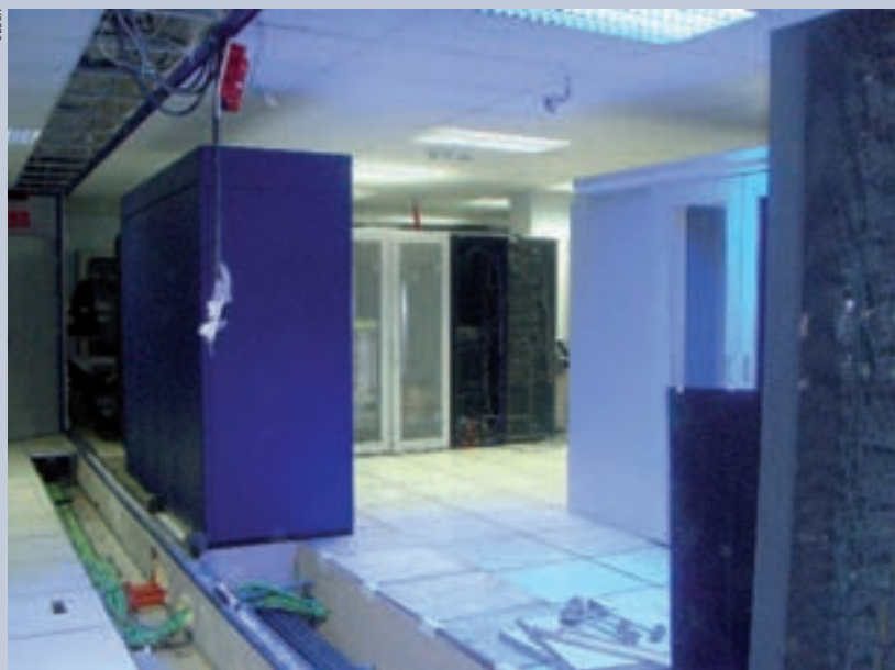
Imatge del procés d'adequació de l'estructura perimetral del CPD.
