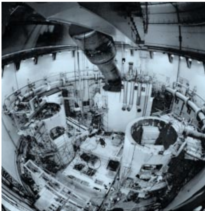
Substitució d'un generador de vapor a la central de Ringhals 3 (Suècia) el 1995.
