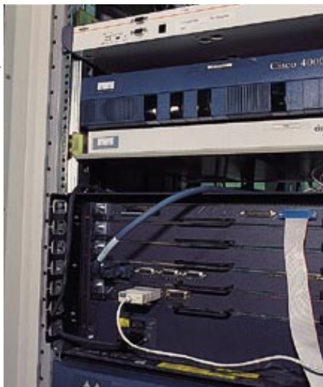
▲ El router que actua com a Network Acces Server (NAS) per al servei d'accés remot.
